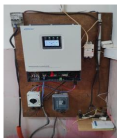
Pose du nouvel onduleur au Centre de Santé
